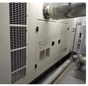
Figure 169: Bio-Diesel Generator
